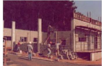
Superestrutura e alvenaria.
