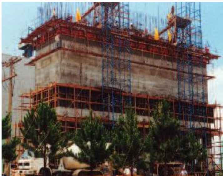
Forma deslizante paredes dos silos
