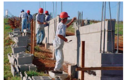
Execução da alvenaria.
