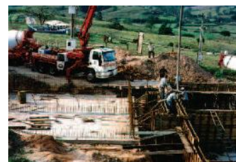
Concretagem das caixas da ETA
