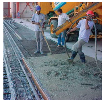
Concretagem do trilho.
