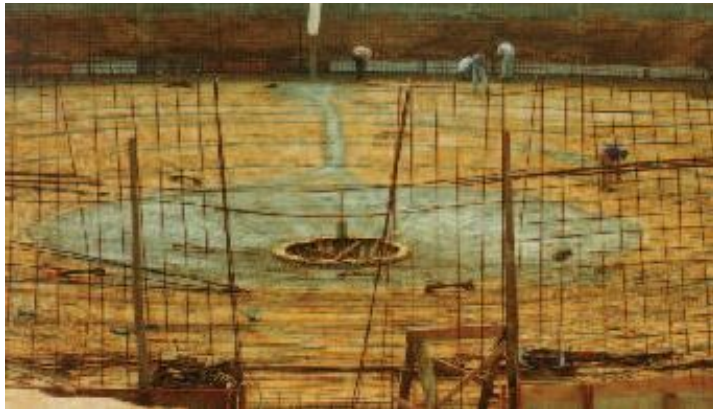
Ferragem laje fundo do espessador.
