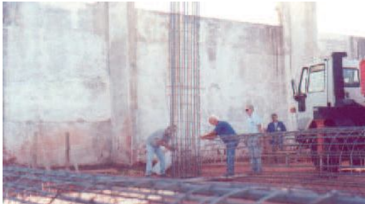
Ferragem tubulões
