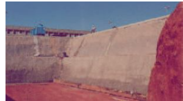
Escavação e estabilização talude..
