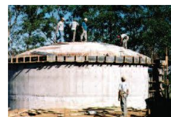
Execução de forma reservatório.
