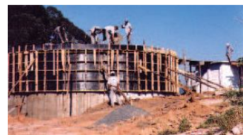
Concretagem do reservatório
