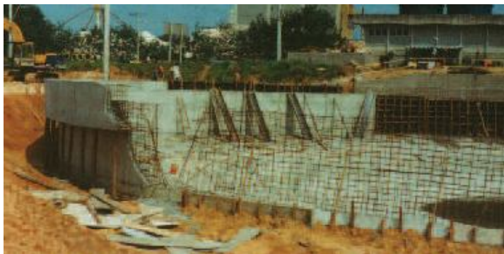
Concretagem das paredes do espessador.
