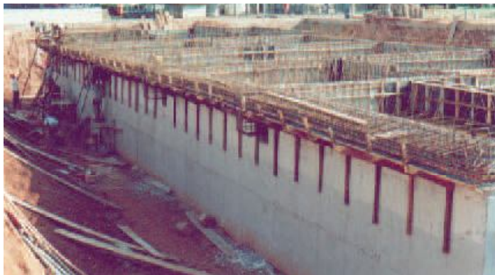
Vista panorâmica da estrutura de travamento.
