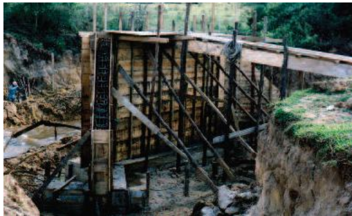
Execução de forma cabeceira da ponte.
