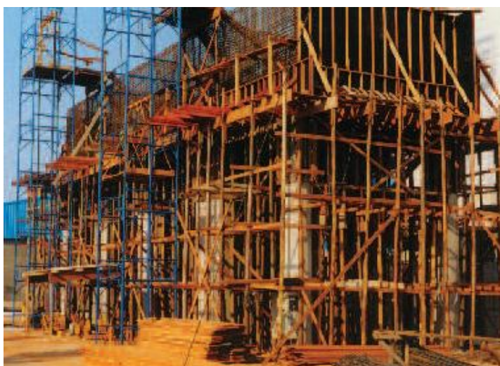
Superestrutura dos silos
